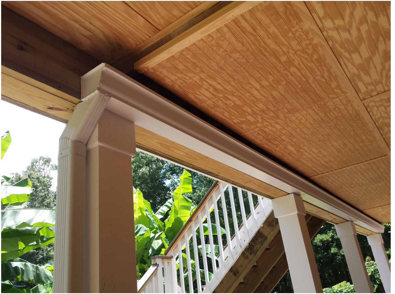
Carport Diagnose Vollversion Crack
